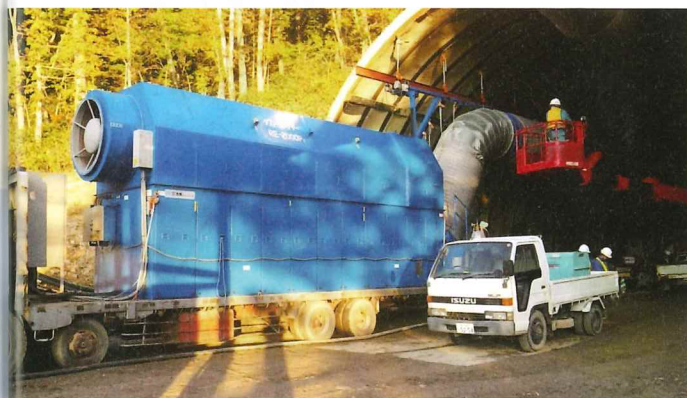
山岳トンネル工事用の大型集塵機。毎回、顧客の要望に合わせて必要なユニットを組み立てている
