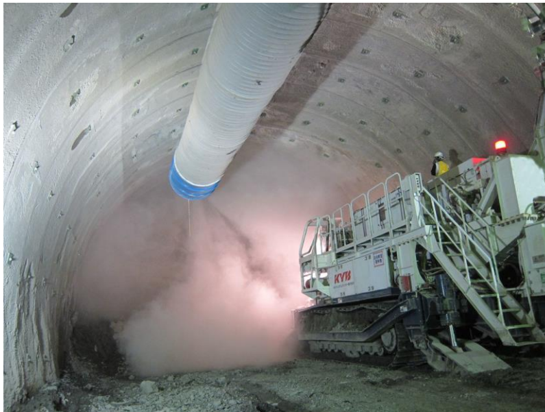
集塵機 レール送り 固定ダクト 伸縮ダクト 駆動部 オーバーハングノズル
